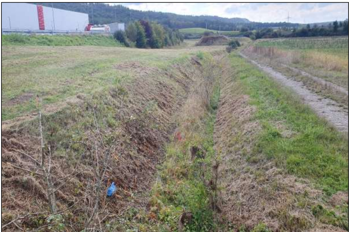
Abbildung 7: Blick nach Westen auf die südliche Grenze des Geltungsbereiches mit Graben und Übergang zur Zufahrt für das bestehende Werk. Foto: R. Bolz, 24.09.2024.
